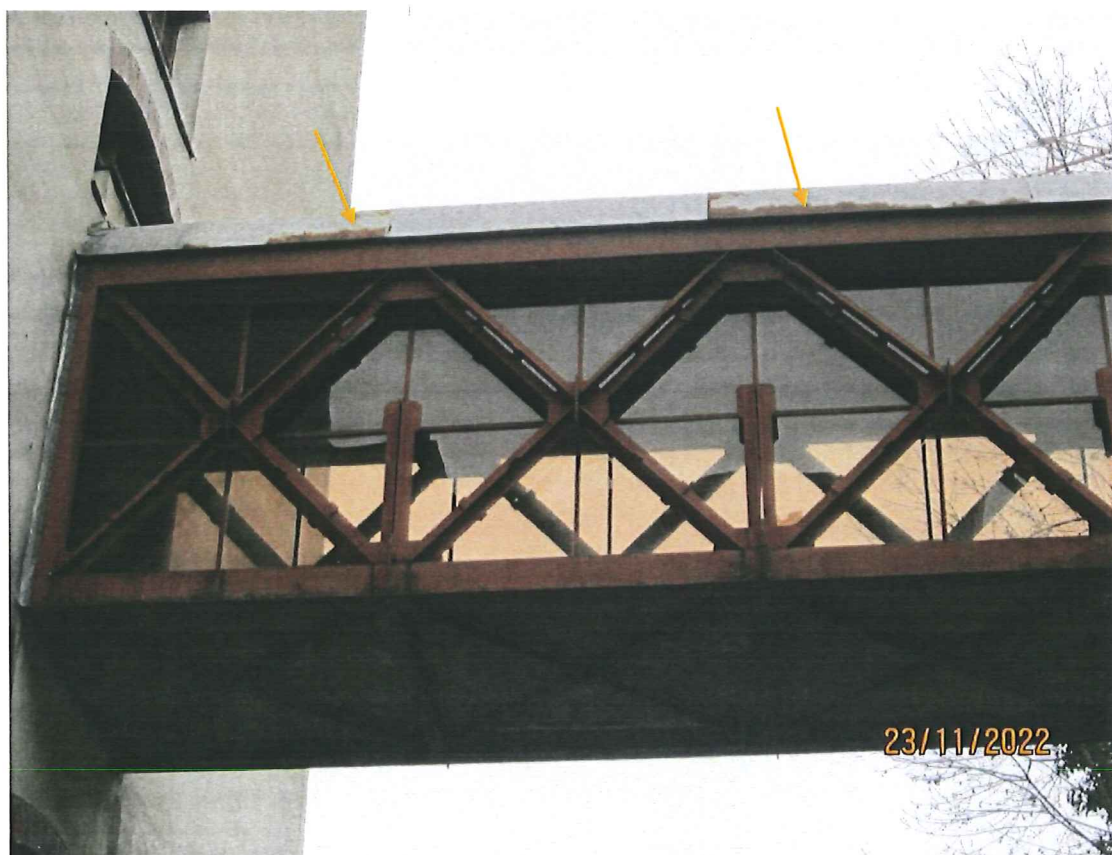
Fot. 8. Łącznik na styku z magazynem książek. Korodujące pokrycie z blachy
