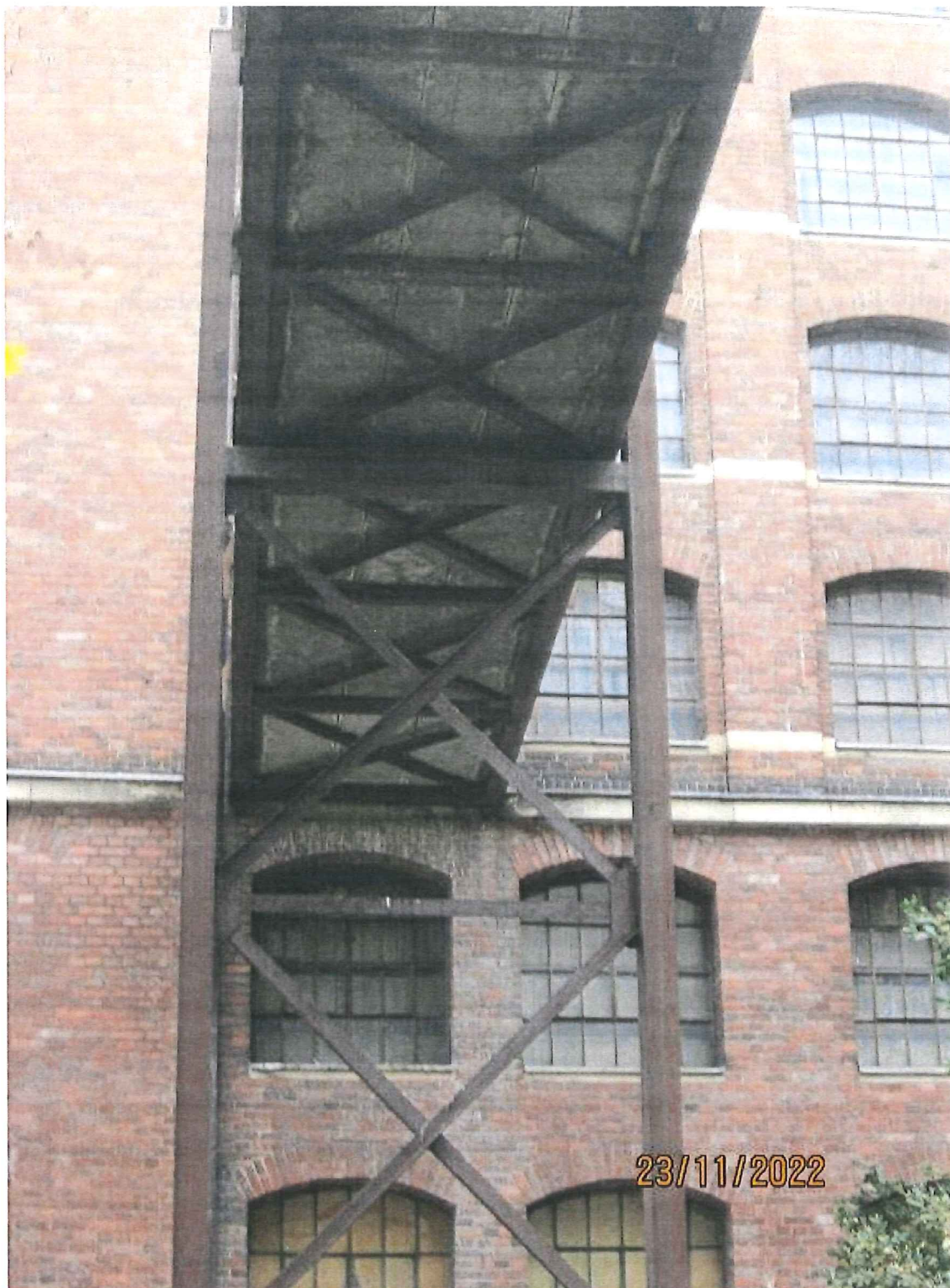
Fot. 9. Widok od spodu – oparcie na budynku biblioteki. Podłoga łącznika nie jest izolowana termicznie
