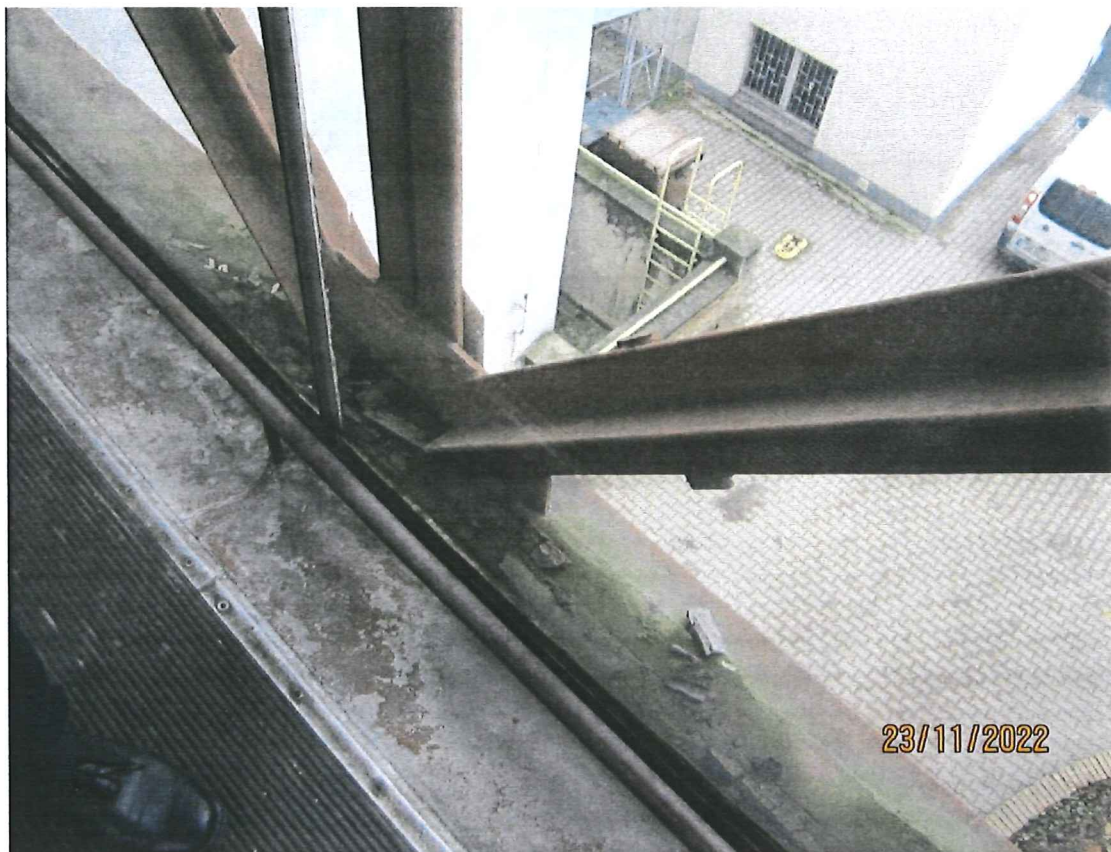
Fot. 3. Węzeł kratownicy nośnej. Widoczne ślady korozji. Zalegające śmieci zatrzymują wilgoć i przyspieszają korozję
