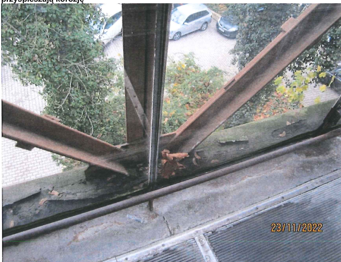
Fot. 4. Węzeł kratownicy nośnej. Widoczne ślady korozji. Zalegające śmieci zatrzymują wilgoć i przyspieszają korozję
