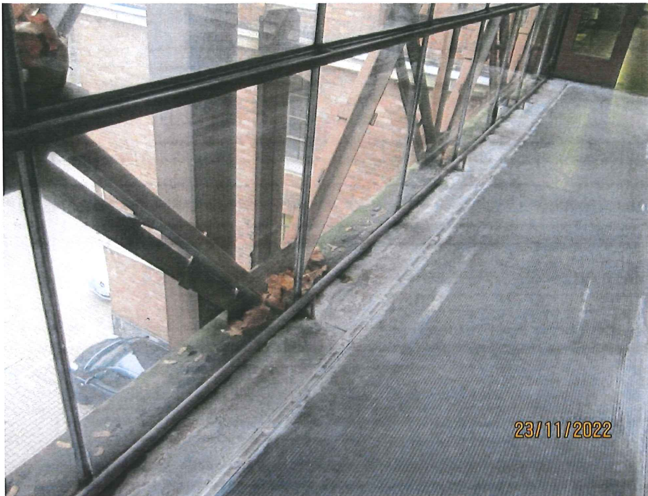
Fot. 5. Węzeł kratownicy nośnej. Widoczne ślady korozji. Zalegające śmieci zatrzymują wilgoć i przyspieszają korozję. Widoczne niewielkie zawilgocenia posadzki na styku ze szkleniem
